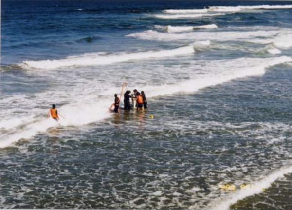
写真-6 砕波帯での打設作業風景
