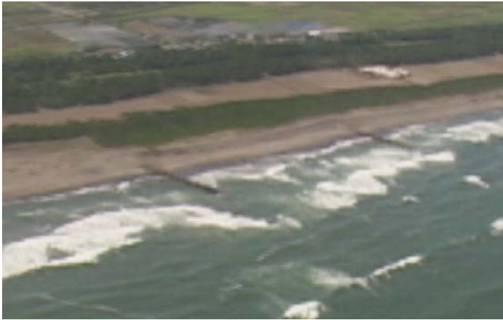
写真-2 突堤付近のリップチャンネル
